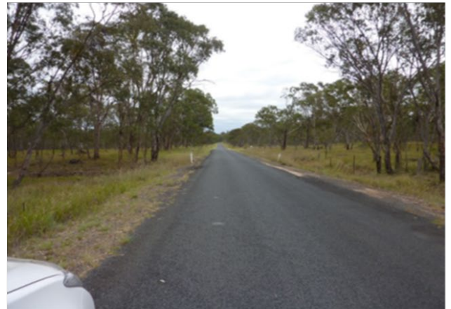
(d) Sealed Road – Condition 2 (Torryburn Road)
